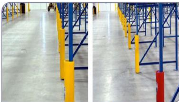
شکل ۳-۲. حفاظت از پایه‌های قفسه‌ها
